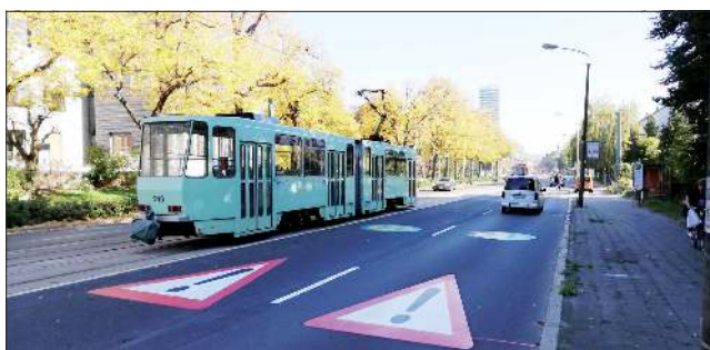
Die neue Haltestellenmarkierung in der Heilbronner Straße.
