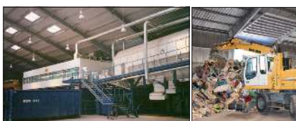
Eine hochmoderne Anlage.
