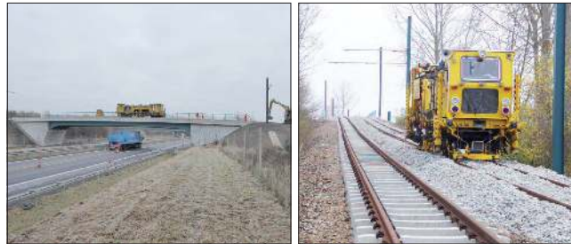
Restarbeiten auf der Brücke und Erneuerung des Außengleises.
