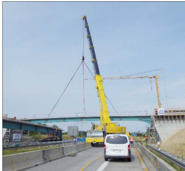
Montage des 2. Trägers. Fotos rechts: Antransport der 5 Träger, Komplettierung der Bewehrung, Betonieren der Fahrbahn und Gleismontage. Fotos (5): SVF
