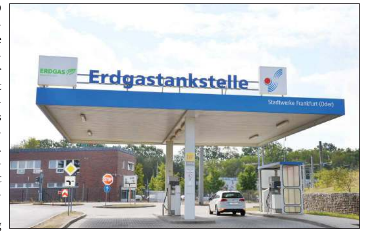
Die Erdgastankstelle in Neuberesinchen. Foto: SWF
