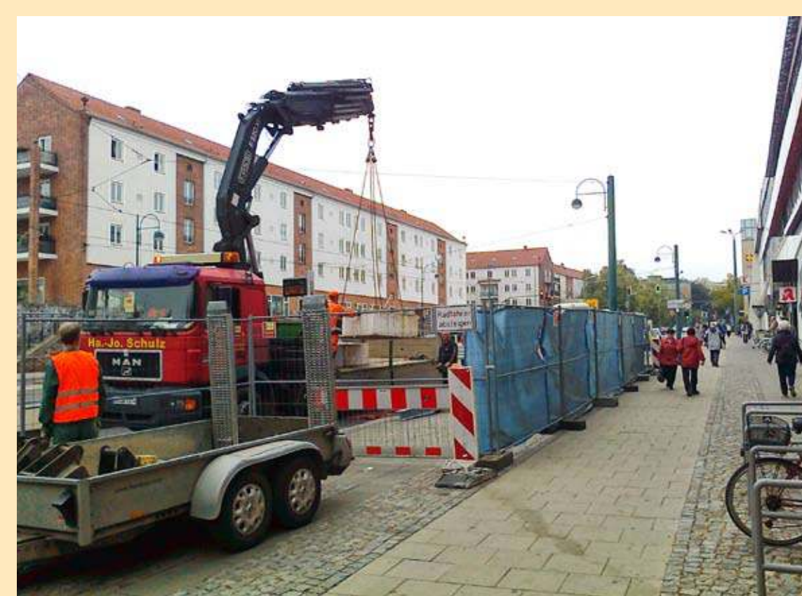
Baustelle Heilbronner Straße
