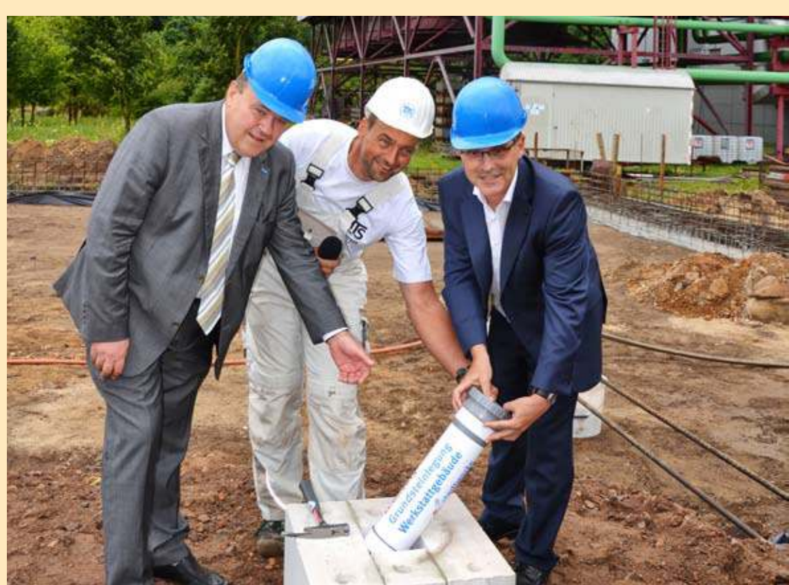
Grundsteinlegung für neues Betriebsgebäude
