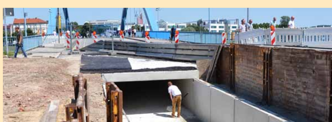
Brückenbauarbeiten für die Fernwärmetrasse
