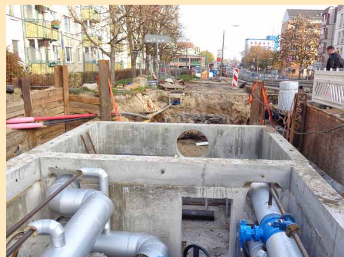
Fernwärmebaustelle in der Rosa-Luxemburg-Str.
