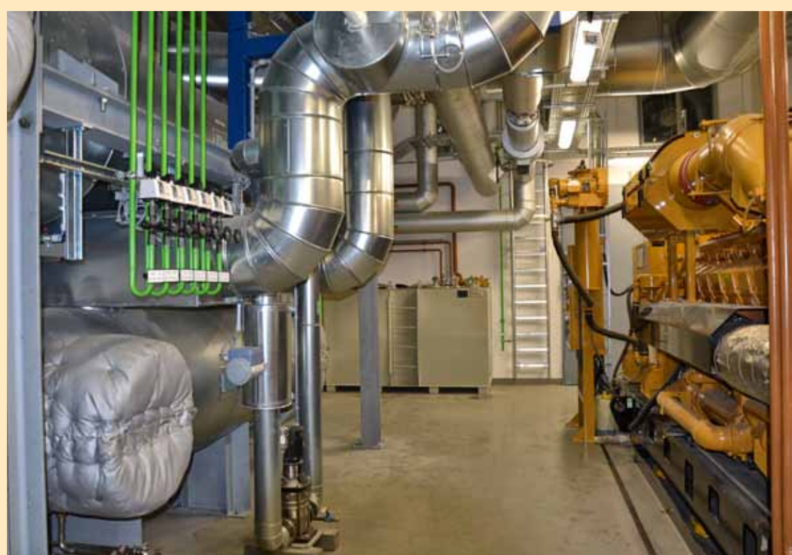
Inbetriebnahme des BHKW Süd
