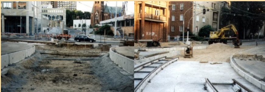
Baustelle Bahnhofstraße der SVF, Juni 1995
