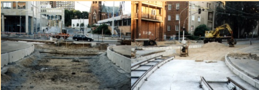
Baustelle Bahnhofstraße der SVF, Juni 1995
