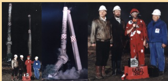
Spektakuläre Sprengung der letzten Schornsteine des ehemaligen Kraftwerkes in Finkenheerd
