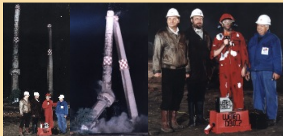
Spektakuläre Sprengung der letzten Schornsteine des ehemaligen Kraftwerkes in Finkenheerd
