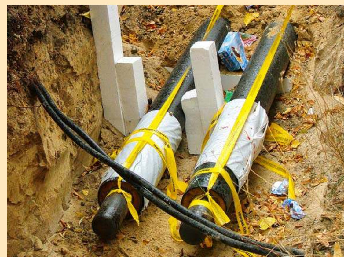
Neubau von 914 m Fernwärmetrasse
