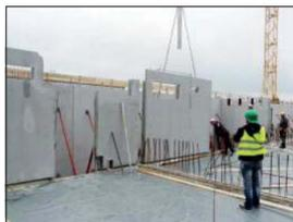
Montage der Wandplatten im Rohrkanaal im Erdgeschoss.
