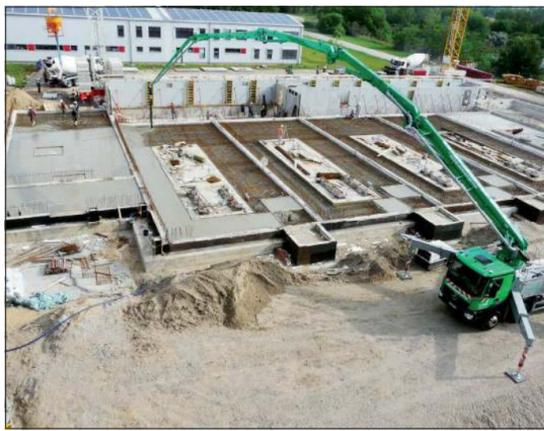
Betonage der ersten Bodenplatten im Erdgeschoss.
