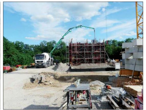
Betonage der Wände im Treppenhaus und Fahrstuhlschacht.
