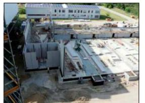
Die Wandplattenmontage mit Hohlwänden im Erdgeschoss.
