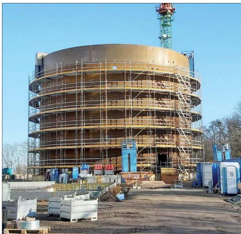
Der Wärmespeicher kurz vor der Fertigstellung.
