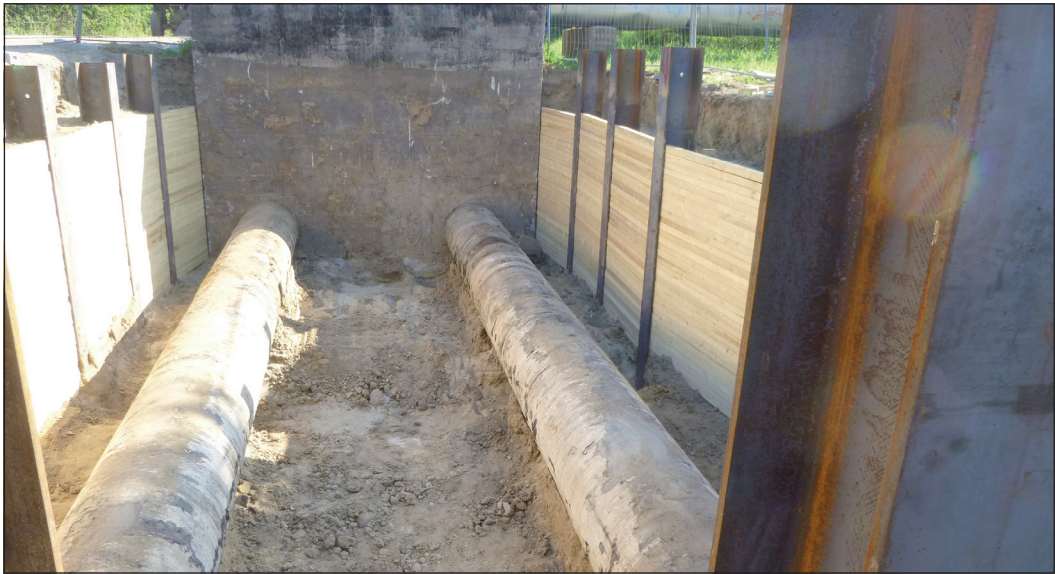
Demontage des alten Rohrleitungsbestandes. Fotos (3): SVF
