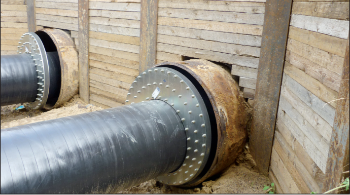
Exzentrische Doyma-Dichtungen.
