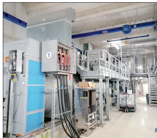
Vorbereitungen zur Inbetriebsetzung von „Bertha“, dem Motor Nummer 1 (links) und ihre Wärmeauskopplung aus dem Motorölkreislauf.
