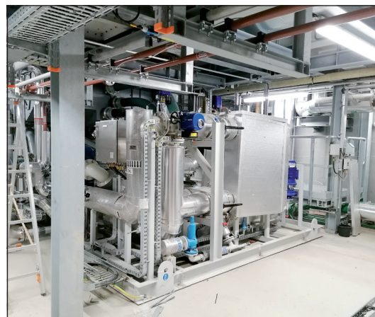
Vorbereitungen zur Inbetriebsetzung von „Bertha“, dem Motor Nummer 1 (links) und ihre Wärmeauskopplung aus dem Motorölkreislauf.
