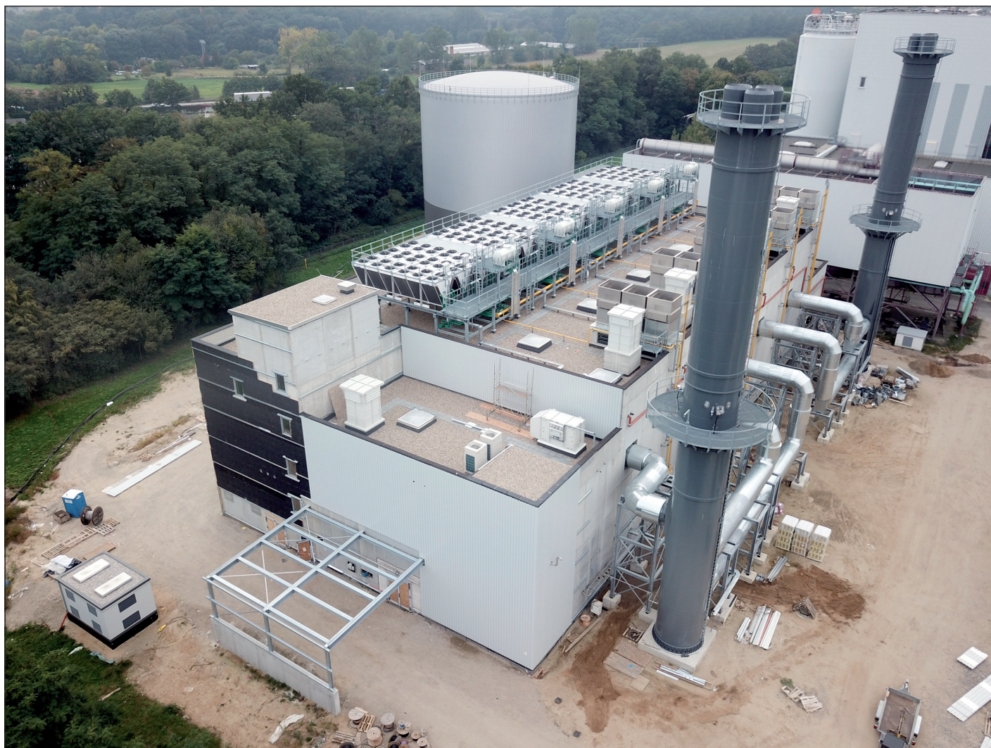
Blick auf die Gasmotorenanlage.
