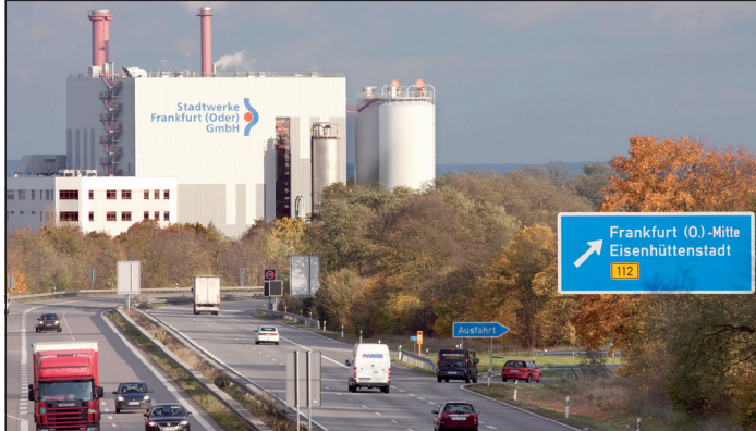
2000 Das neue Heizkraftwerk
