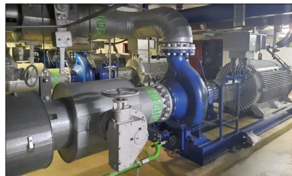
Fotos (3): SWF Die Dampfturbine und die Fernwärme-Umwälzpumpen.
