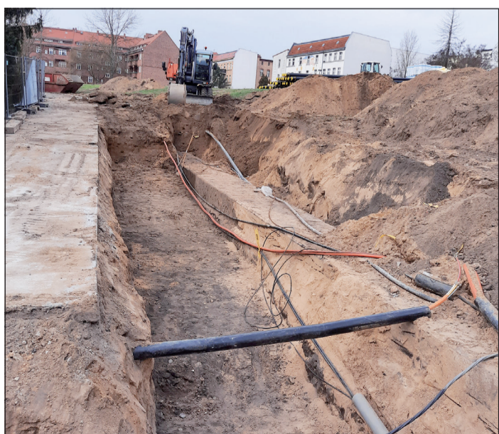
Netzausbau in der Mixdorfer Straße.
