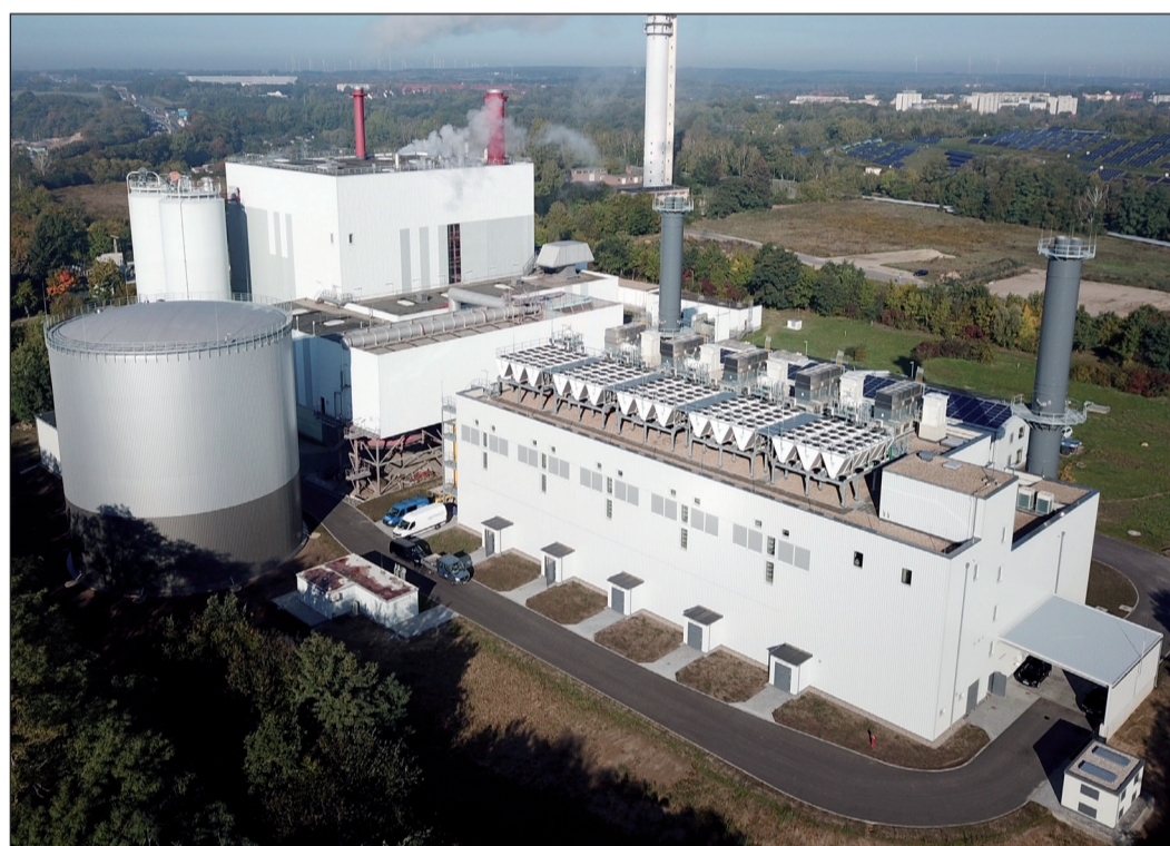
Unser modernes Heizkraftwerk in Frankfurt (Oder).
