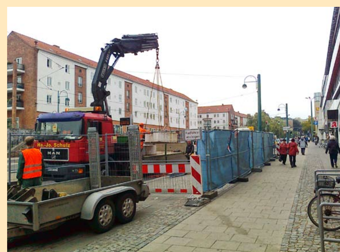
Baustelle Heilbronner Straße
